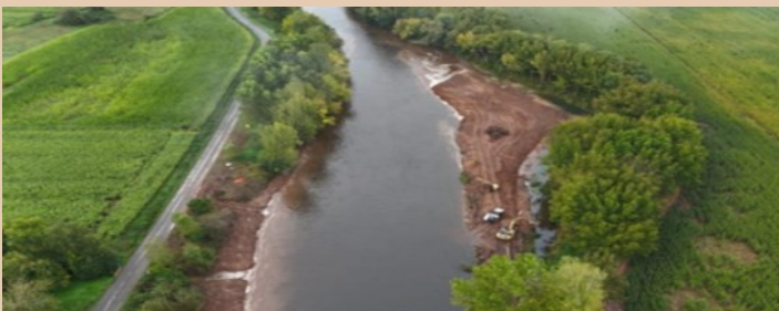
Ilot de Biars après 2 semaines de travaux
